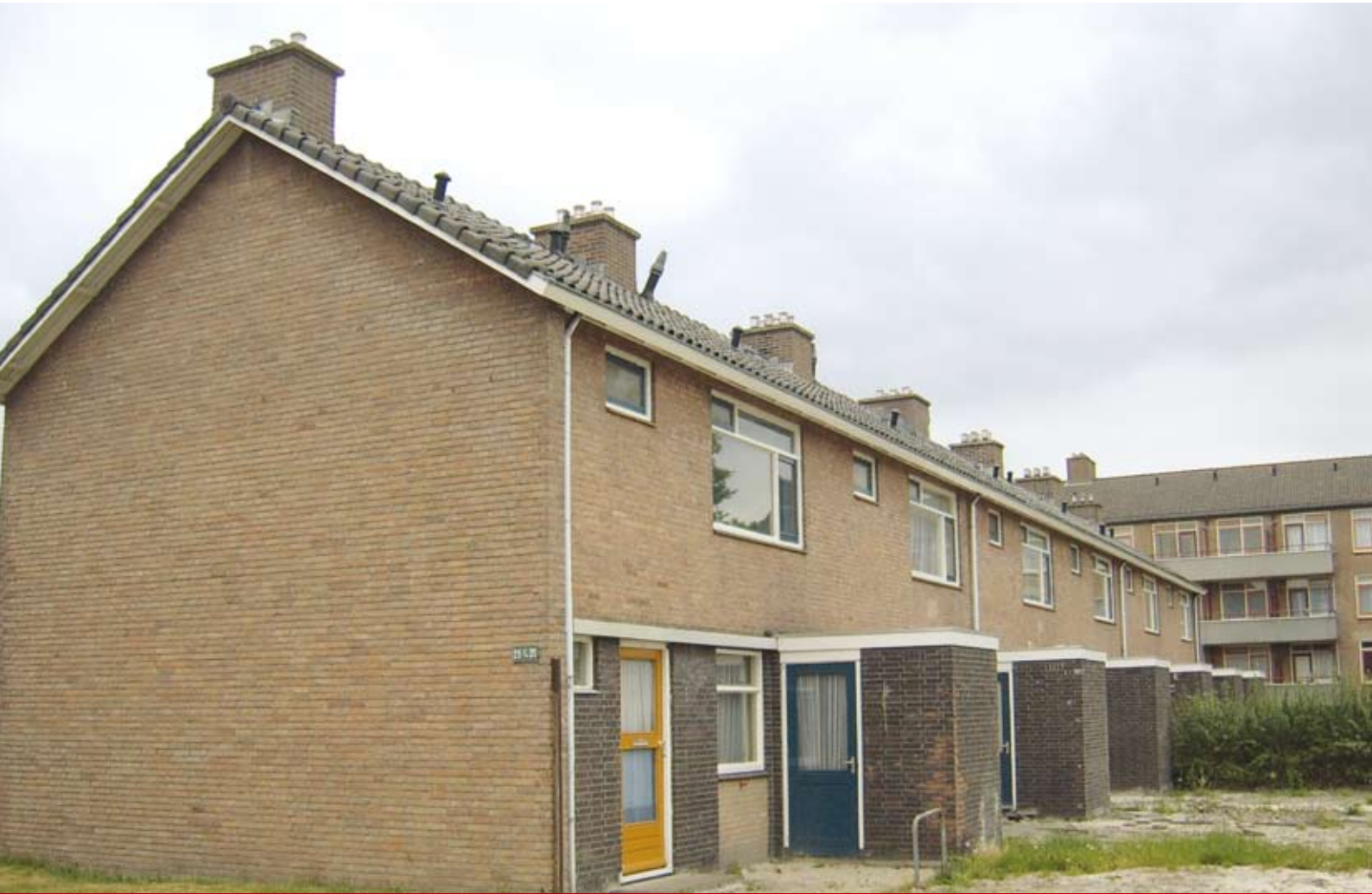
Prima eengezinswoningen wachten op de slopershamer in Stadskanaal.
